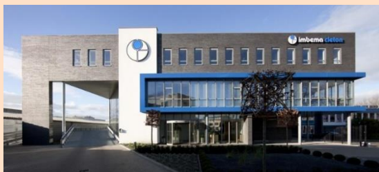
Nieuwbouw Imbema Cleton - kantoor 955 m 2 , bedrijfsruimte 1.735 m 2 , best. magazijn 1.410 m 2 Bron: Heembouw & van Es architecten
