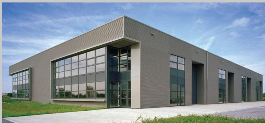
Bron: Plegt, bouwgroep
