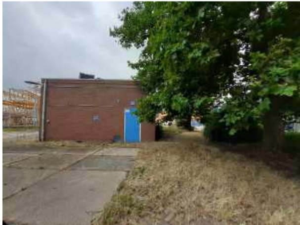
Foto 24: Locatie IV-a (Gebouw N2)
