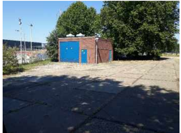
Foto 25: Locaties IV-b (Twee containers) & IV-c (Verwarmde container)
