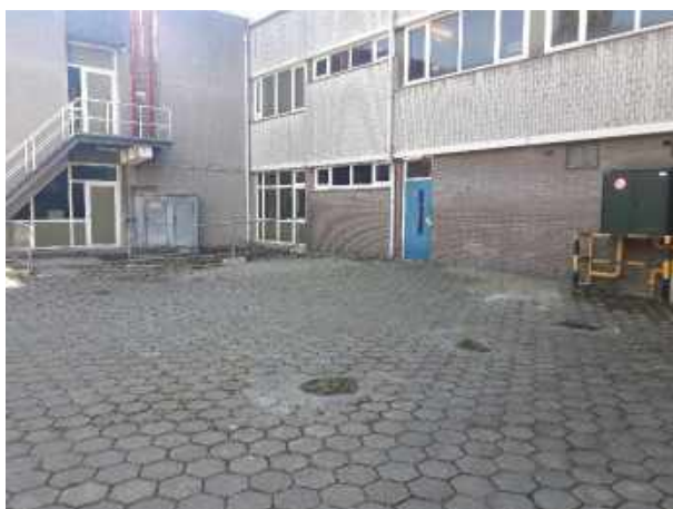
Foto 53: Locatie VII-c/VII-h (Proeffabriek, laboratorium, etc.)
