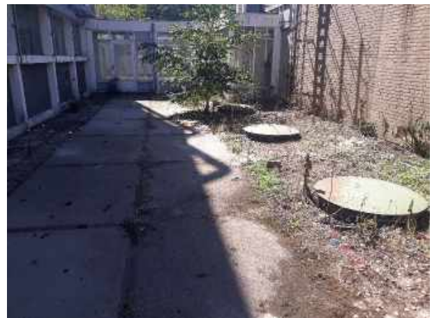
Foto 30: Locatie V-d (Ondergrondse tanks)
