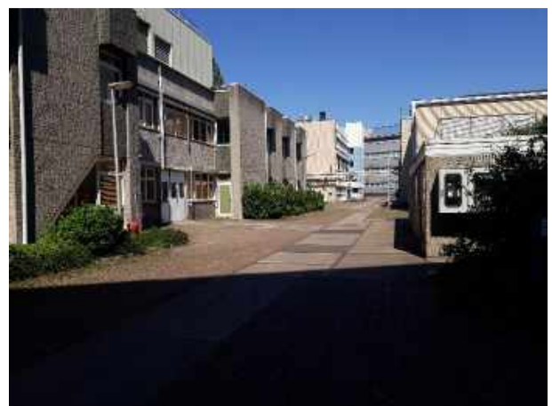
Foto 54: Locatie VII-c/VII-h (Proeffabriek, laboratorium, etc.)
