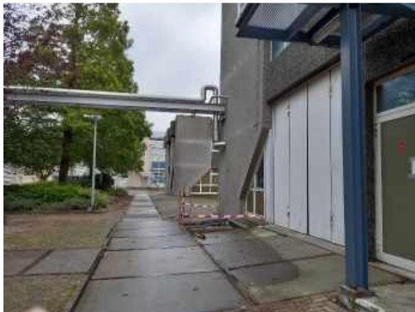
Foto 51: Locatie VII-c/VII-h (Proeffabriek, laboratorium, etc.)
