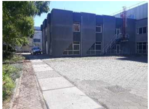
Foto 52: Locatie VII-c/VII-h (Proeffabriek, laboratorium, etc.)
