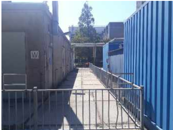
Foto 33: Locatie V-g (Opslag oplosmiddelen en koelinstallatie)
