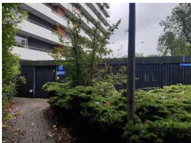
Foto 3: Locatie I-c (Transformatorruimte)
