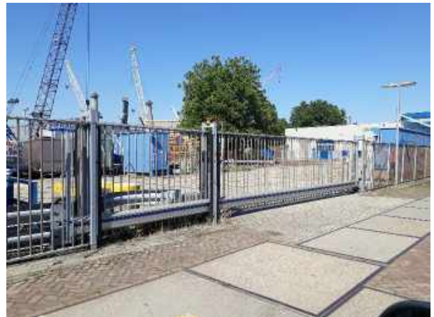
Foto 42: Locatie VI-f (Bunker)
