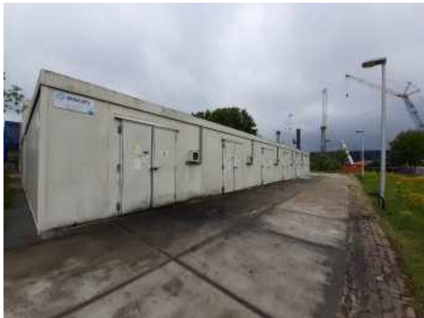
Foto 20: Locatie III-e (Koelcellen) incl. brandplek
