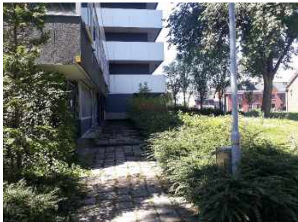
Foto 1: Locatie I-a (HBO-tank)
