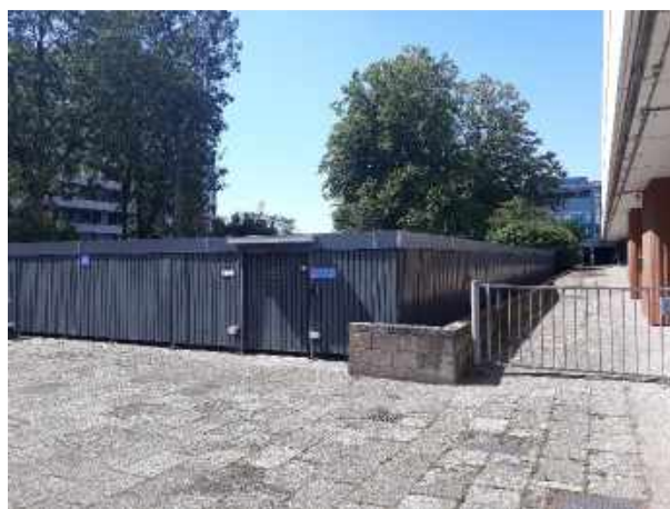
Foto 4: Locatie I-c (Transformatorruimte)
