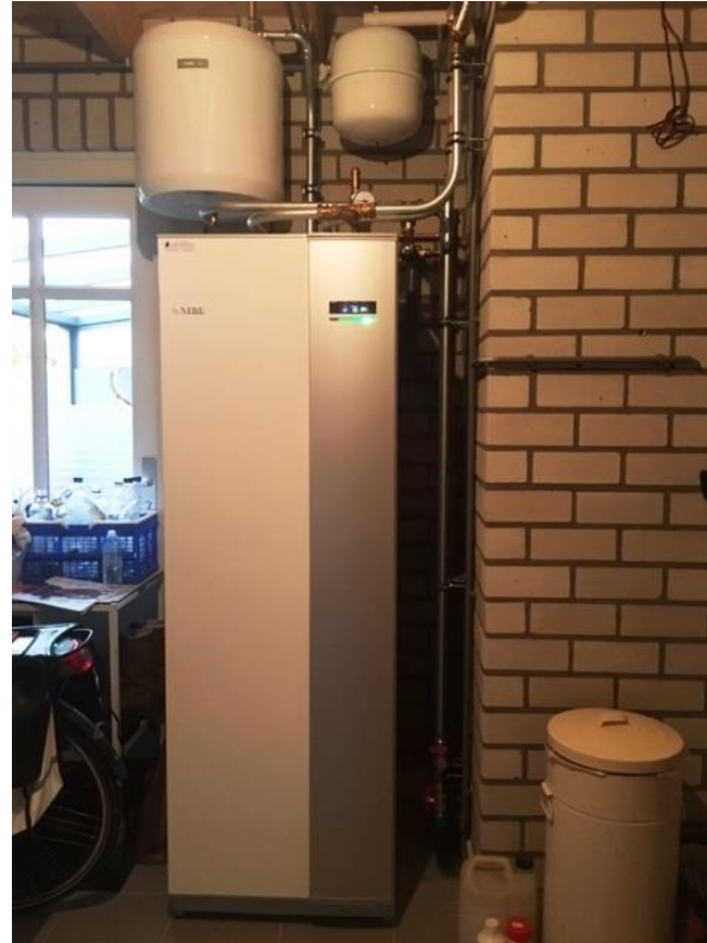
Voorbeeld installatie all-in one warmtepomp met buitenunit
