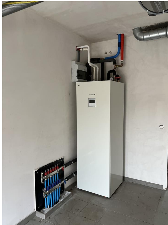
Voorbeeld installatie all-in one warmtepomp en bodemlus
