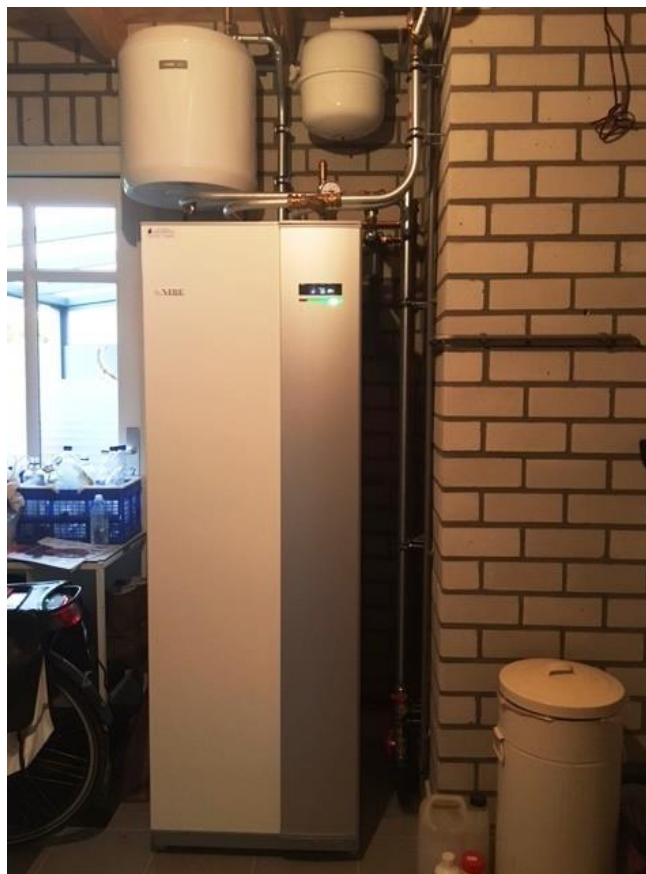
Voorbeeld installatie all-in one warmtepomp met buitenunit
