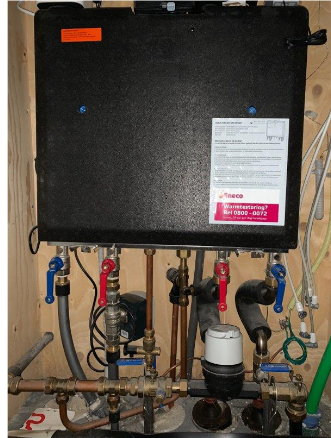
Voorbeeld afleverset warmtenet
