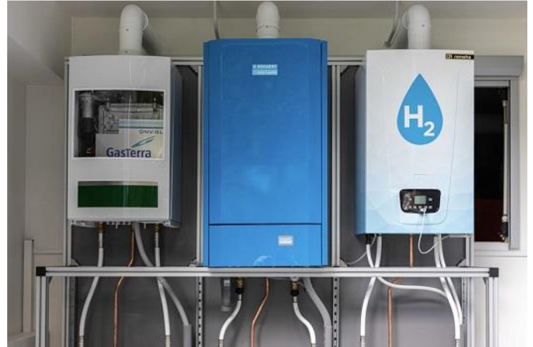
Afbeelding: HR-ketel installatie op basis van waterstof
