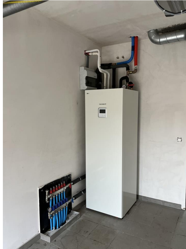
Voorbeeld installatie all-in one warmtepomp en bodemlus
