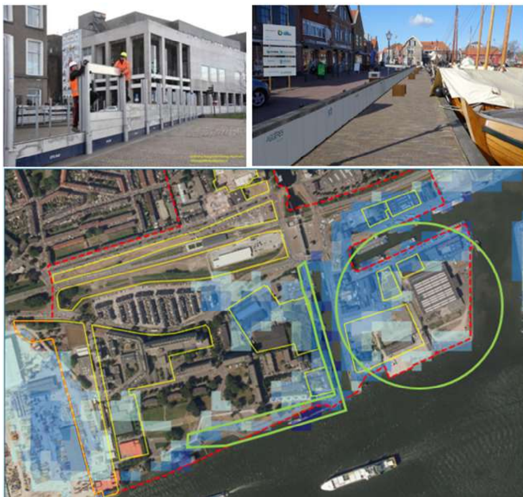
Figuur 6.25 Demontabele waterkering Waalkade Nijmegen (links) en Flexibele waterkering in Spakenburg (rechts)
