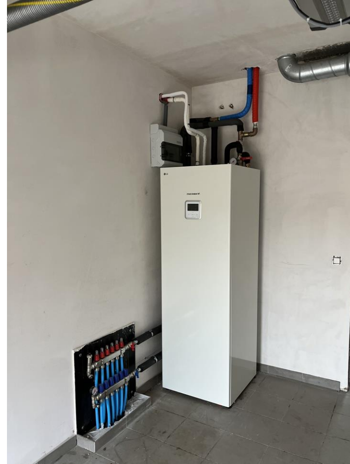
Voorbeeld installatie all-in one warmtepomp
