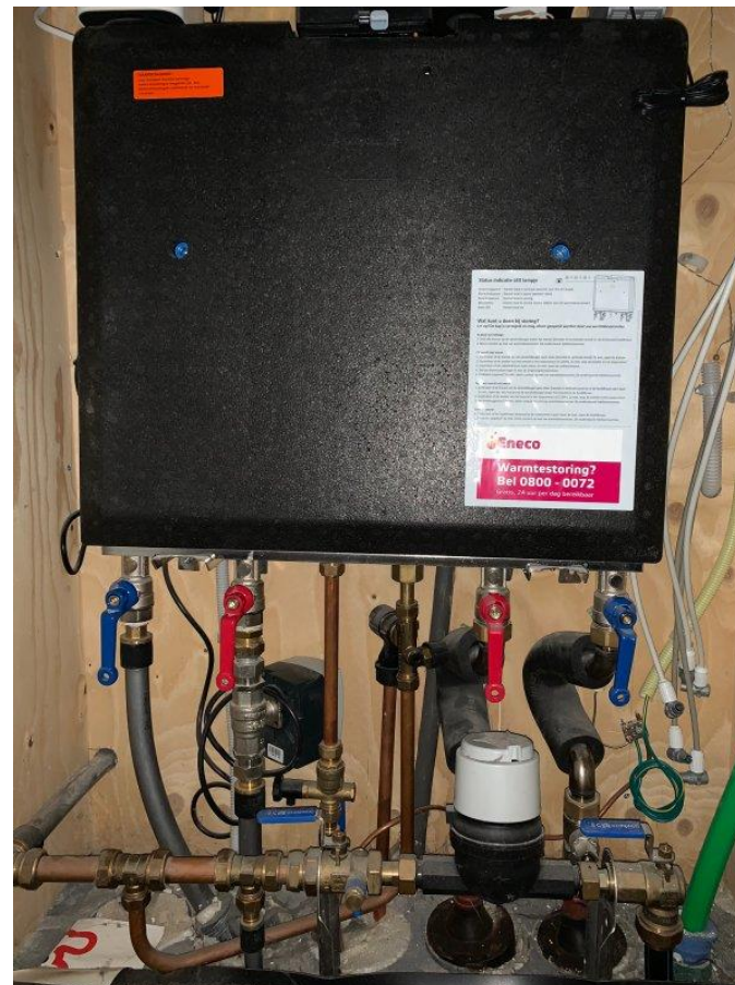
Voorbeeld afleverset warmtenet
